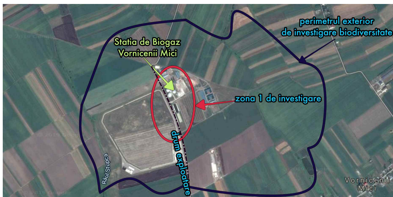
Figura nr. 2-7 Vedere asupra zonei 1 de investigare (aprox 500m) si asupra zonei exterioare de investigare
