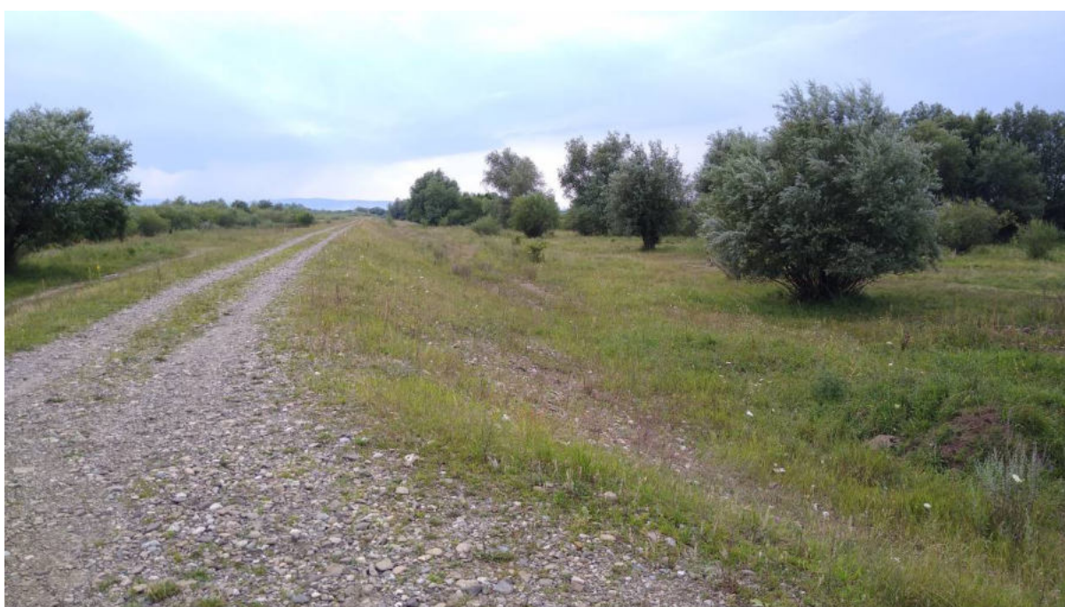
Figură 11. Aspect general, vedere spre nord-vest, conducta proiectată va trece între dig și arbori. Se va evita tăierea arborilor și arbuștilor în faza de execuție a lucrărilor.
