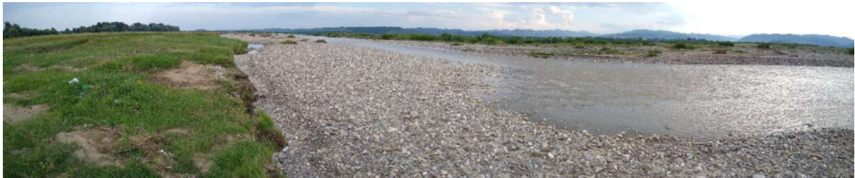
Figură 5. Zona traversării râului Moldova. Soluția tehnică propusă este forajul orizontal dirijat, soluție agreată de evaluatori, fiind soluția prin care se evită formele de impact direct.
