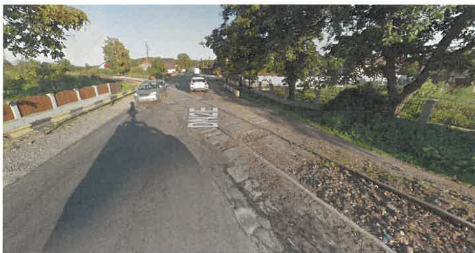
Foto – Amplasamnetul proiectului – Trecere la nivel si terasament cale ferata
