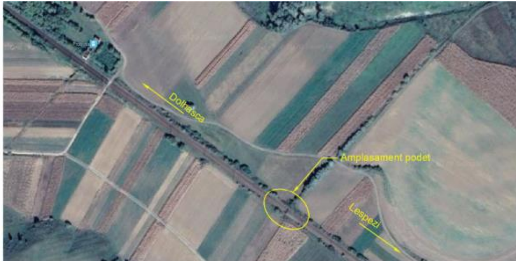
Figura 1 – Amplasamentul poduțului km 401+936
