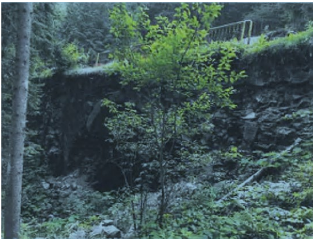
Figura nr. 37 - Vedere aval pod
