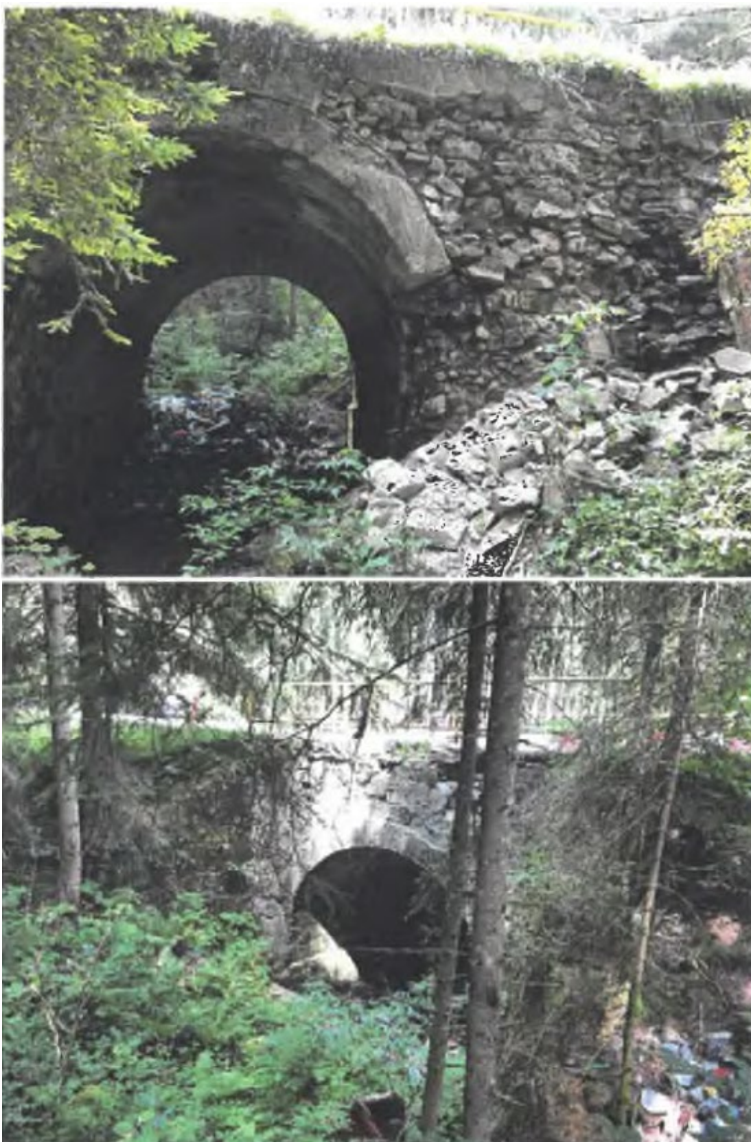
Figura nr. 36 - Imagine cu valea necadastrată, secțiunea podului, amonte, albie abruptă, vegetație și material adus de viituri
