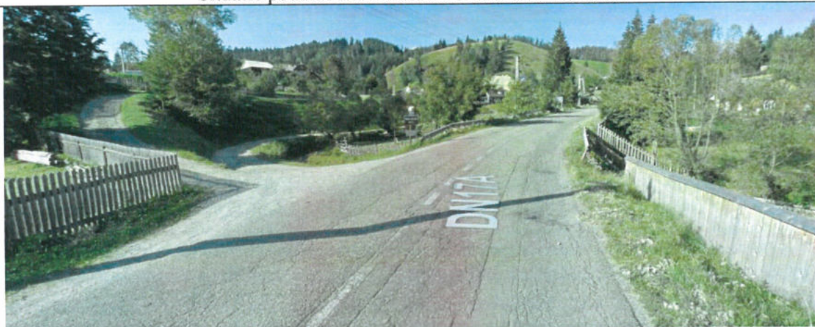
DN 17A – zona Km 29+780 Sens de deplasare spre Sucevita
