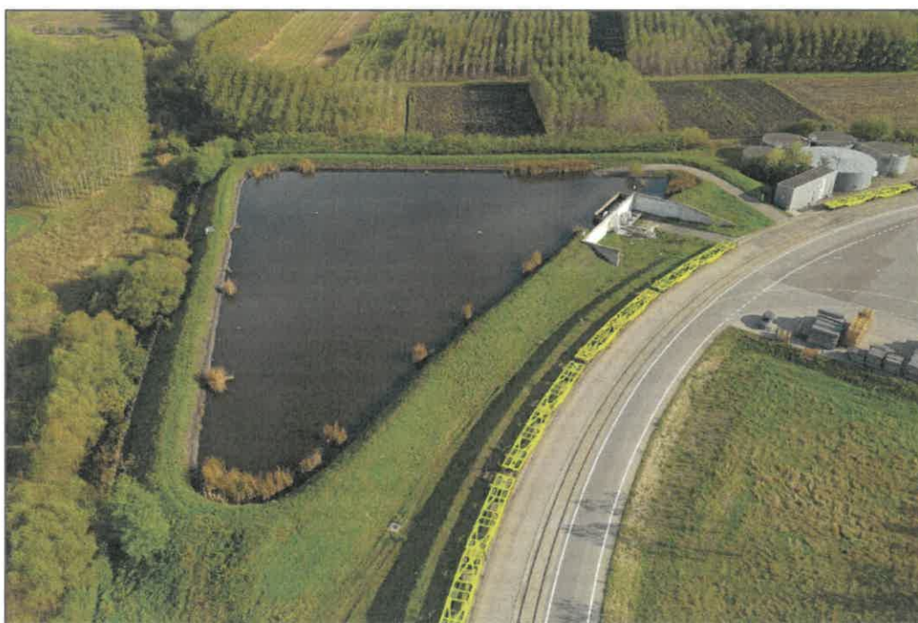
Foto 4 – Bazin de retenție apă pluvială de categoria I
