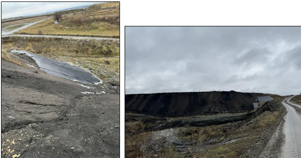
Pregătirea celulei 4 pentru depozitarea deșeurilor
