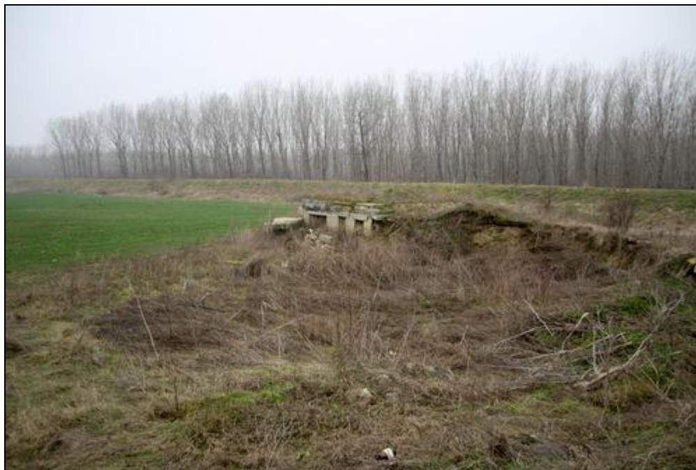
Figura nr. 61 – Aspect privind unei structuri ce pare a fi fost o rampă auto. Structura este localizată în interiorul amplasamentului nr. 16, în colțul format de DN 54 Turnu Măgurele – Corabia cu digul de protecție construit în apropiere de cursul râului Olt
