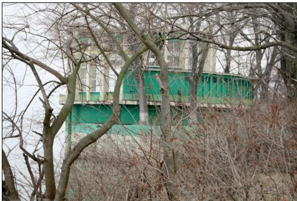
Figura nr. 68 – Clădirea din care sunt furnizate serviciile de captare și transport a apei din fluviul Dunărea (proprietate a S.C. Donau Chem S.R.L.)
