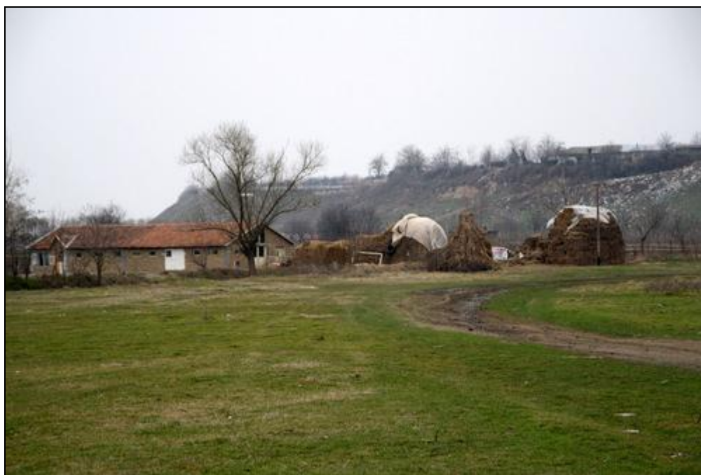
Figura nr. 42 – Aspect privind prezența de construcții pe suprafața de teren vizată pentru extinderea intravilanului în sectorul nord-vestic al amplasamentului nr. 1
