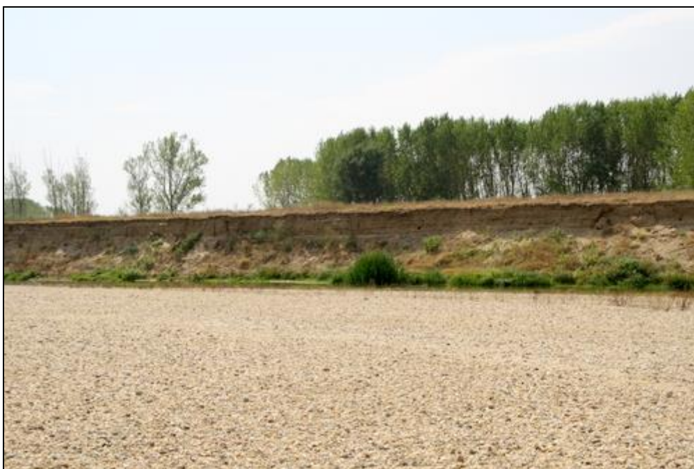
Figura nr. 11 – Aspect privind malul erodat opus plajei nr. 3 situată în zona din aval a amplasamentului proiectului
