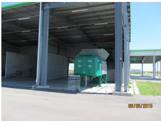
Stația de compostare SC ECO SUD SRL București- Depozit Mavrodin
