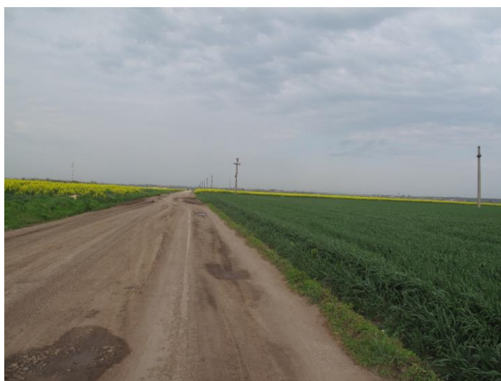
Foto nr.3 – Profil curent drum existent împietruit lățime medie 6,50m
