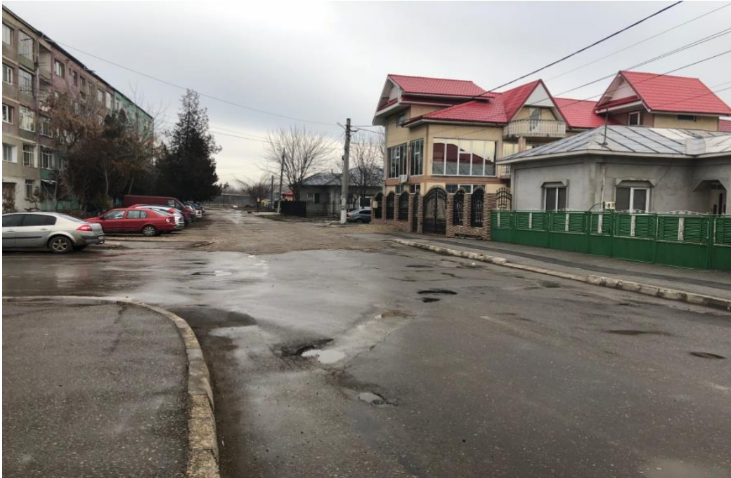
Strada Costache Negri la intersectia cu Strada Mihai Eminescu
