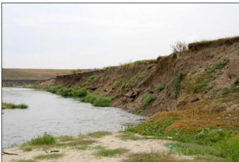
Figura nr. 5 - Aspect privind malul drept al raului Vedea, erodat, imediat aval de amplasamentul proiectului
