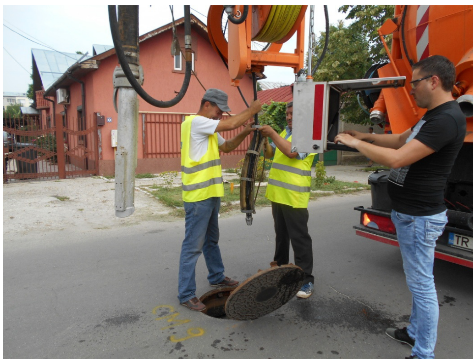
Figura 21 a), b) si c) - Inspectii video CCTV
