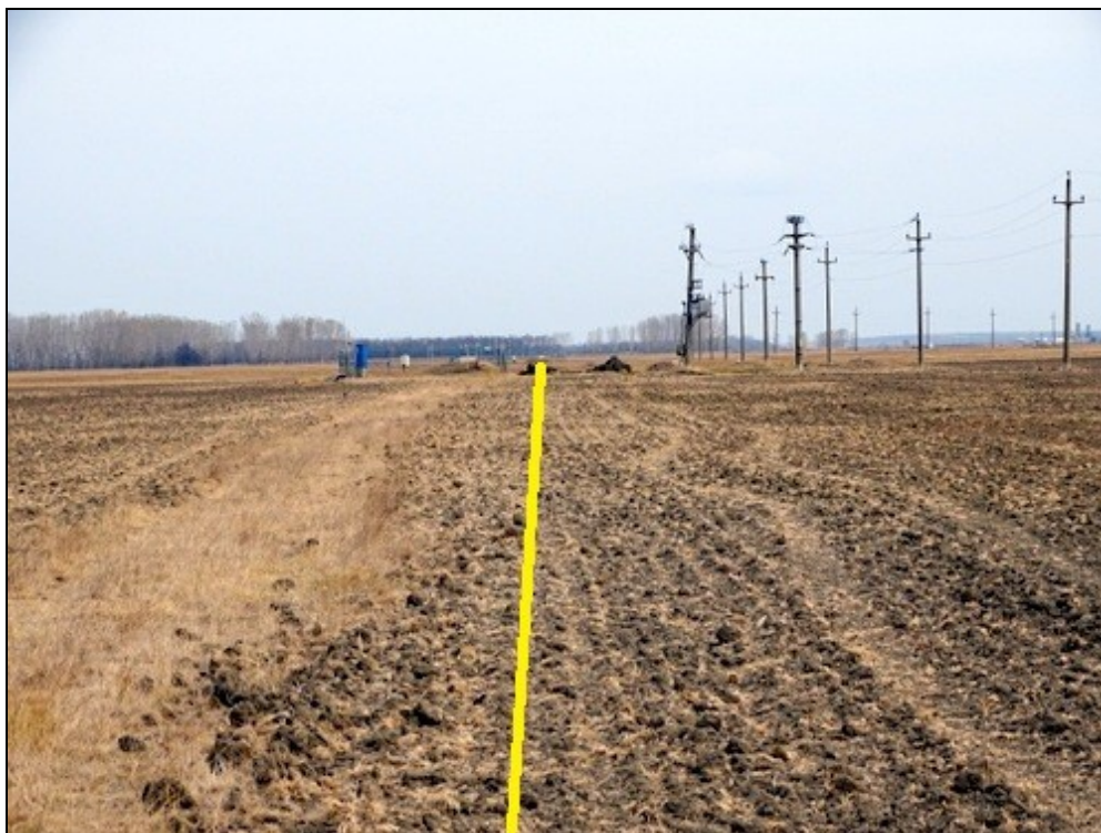
Figura nr. 25 – Aspect privind tronsonul de inlocuire conductă legătură puțuri între puțul nr. 23 și puțul nr. 22
