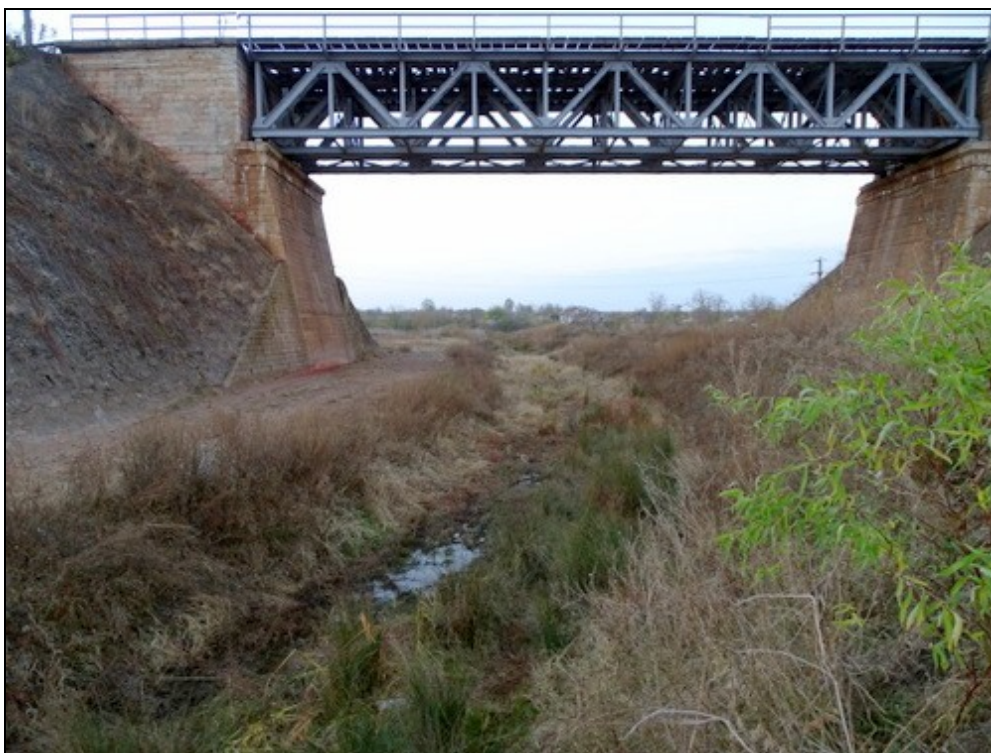
Figura nr. 16 – Aspect privind starea ecologică a pârâului Bratcov în sectorul vizat de realizarea unei subtraversări a unei conducte de aducțiune
