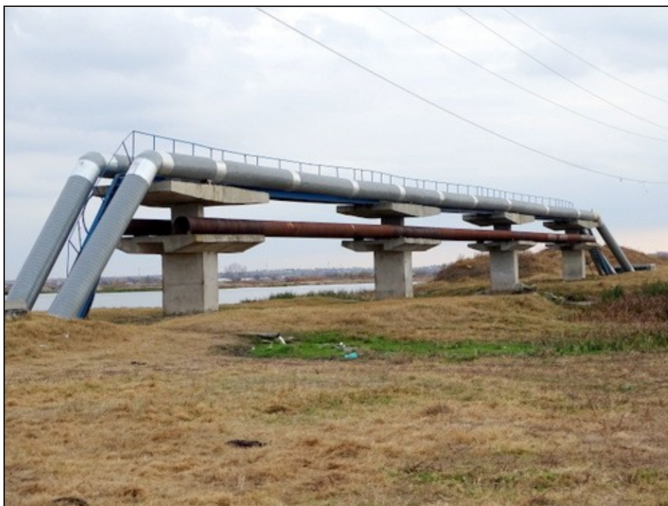
Figura nr. 28 – Aspect privind prezența estacadei în zona pârâului Barâcea pe tronsonul de înlocuire conductă legătură puțuri situat între puțul nr. 20 și puțul nr. 19
