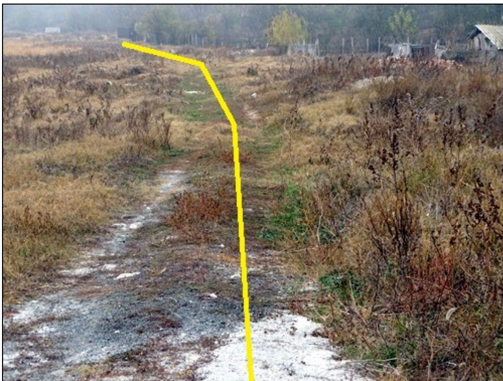
Figura nr. 32 – Aspect privind poziționarea conductei de canalizare (culoare portocalie) și a celei de distribuție a apei la limita vestică a zonei construite a municipiului Turnu Măgurele (culoare albastră) – tronson sudic ce pornește din DN 54 Turnu Măgurele – Islaz pe un drum neamenajat
