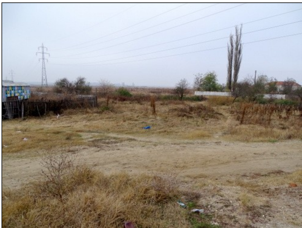
Figura nr. 42 – Aspect privind zona degradată din punct de vedere ecologic a traseului de pozare conductă de canalizare în vecinătatea DJ 546 Turnu Măgurele – Lița
