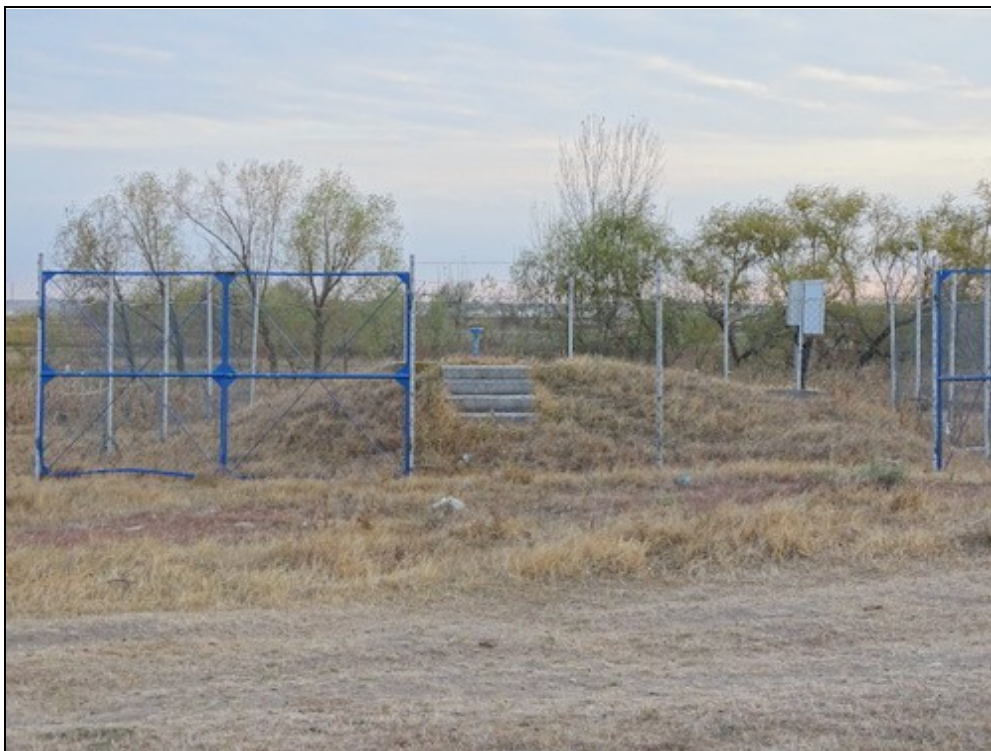
Figura nr. 21 – Perimetrul de protecție a puțului nr. 33 – Peretu
