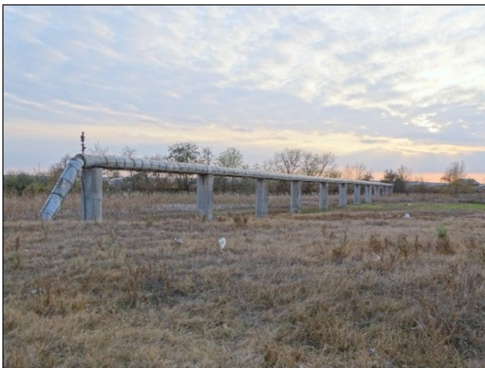
Figura nr. 20 – Aspect privind traversarea conductei de legătură între puțurile 34 și 33 pe o estacadă, deasupra cursului de apă Barâcea
