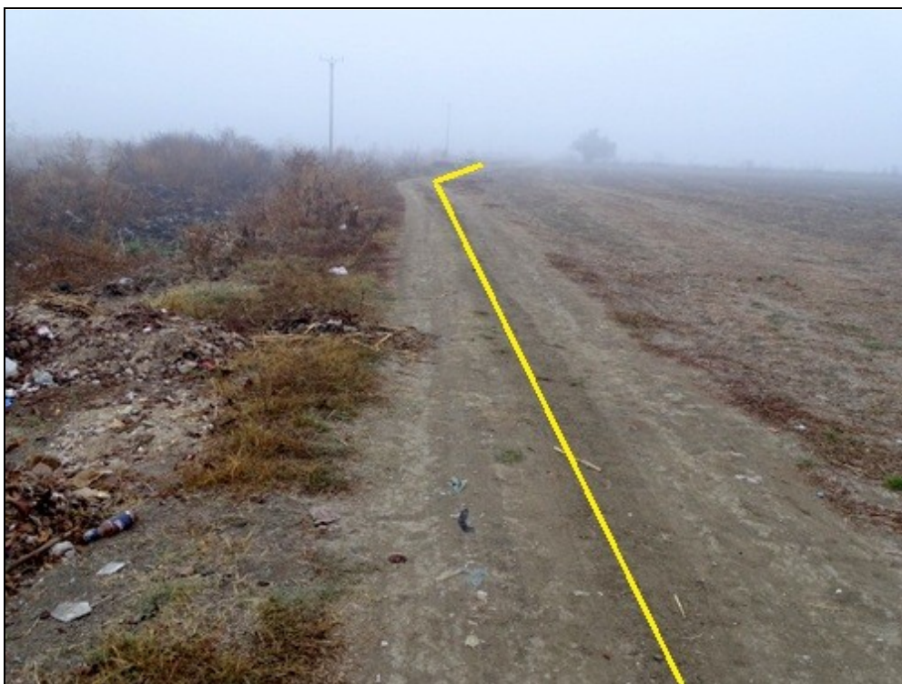
Figura nr. 60 – Aspect privind traseul conductei de evacuare pe un sector de drum agricol denudat (pe direcția nord-vest)
