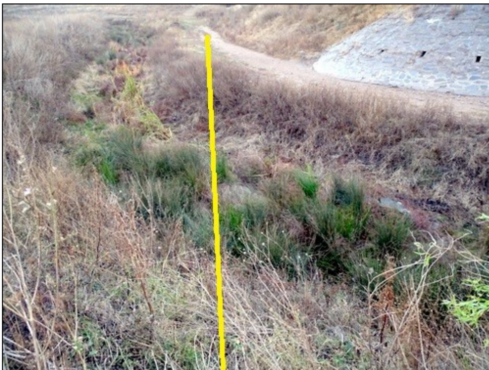
Figura nr. 17 – Aspect privind starea ecologică a pârâului Bratcov în sectorul vizat de realizarea unei subtraversări a unei conducte de aducțiune. Cu linie galbenă este marcat traseul de subtraversare
