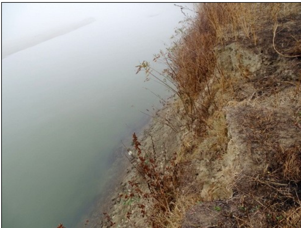
Figura nr. 64 – Aspect privind malul drept al Oltului în zona de amplasare a gurii de evacuare a conductei de evacuare
