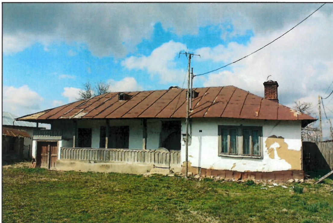
Figura – Casa tradițională cu prispa și beci , DN 6 nr. 2
