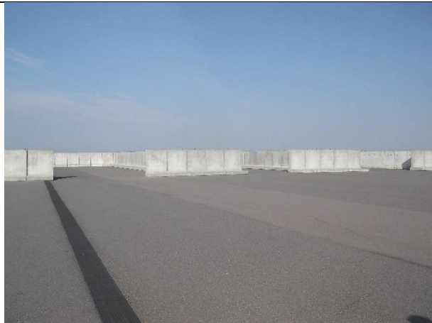
Platformă bioremediere – compartimente stocare
