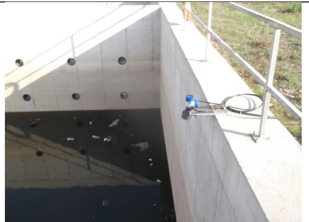
Bazin de colectare și stocare ape pluviale - control
