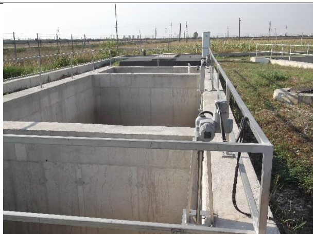
Decantor-separator de produse petroliere
