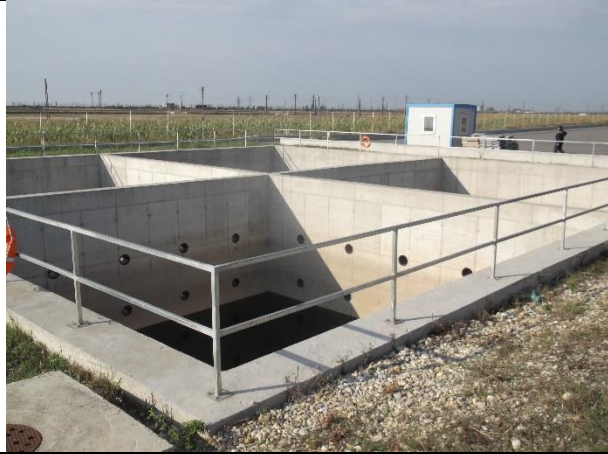
Bazin colectare și stocare ape pluviale
