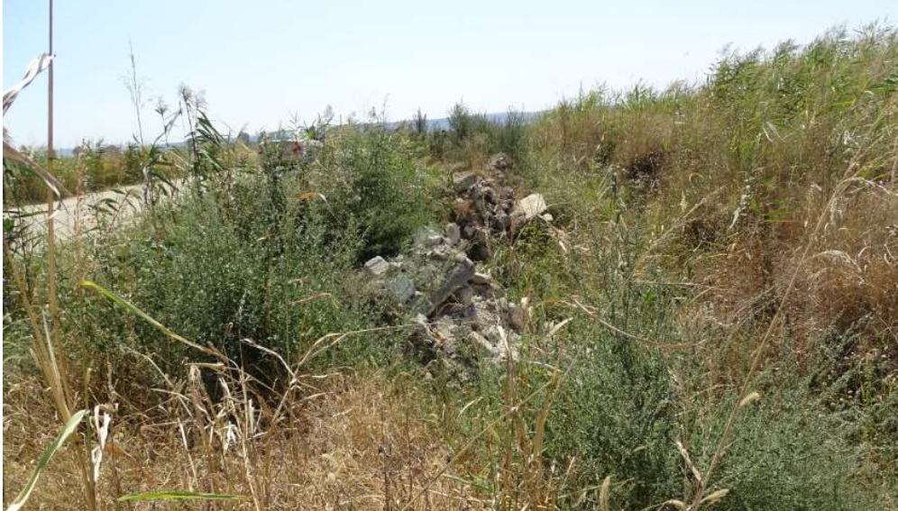
Figura 6 Deseuri din constructie depozitate in zona drumului de acces
