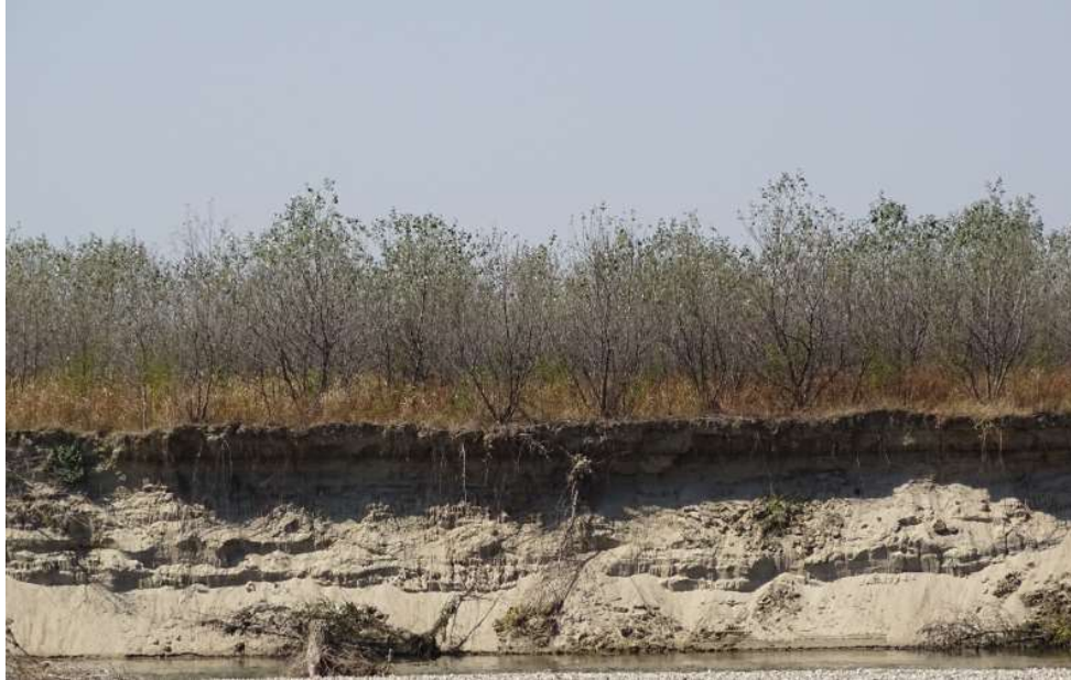
Figura 7 Eroziune mal drept
