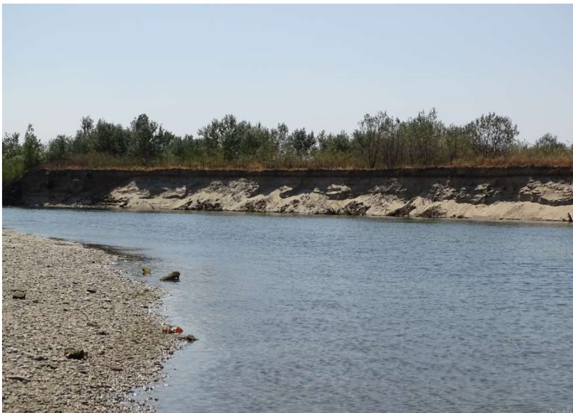
Figura 4 Eroziuni mal drept
