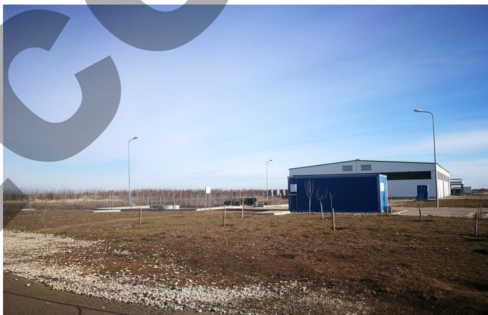
Figura 18. Putul de alimentare cu apă, stația de clorinare și atelierul mecanic/garaj
