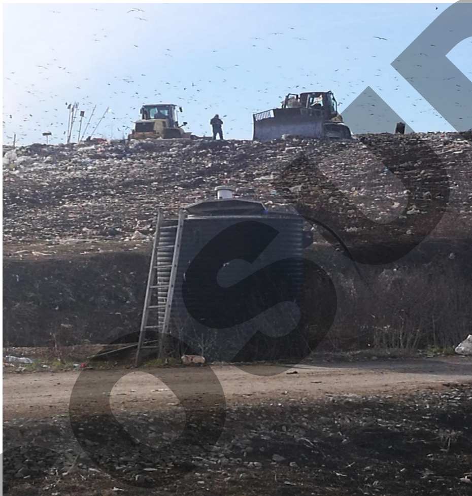
Figura 20. Celula 1 de depozitare a deșeurilor și un cămin de colectare levigat
