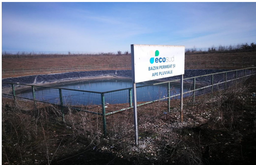
Figura 31. Bazin de retenție permeat și apele pluviale conventional curate
