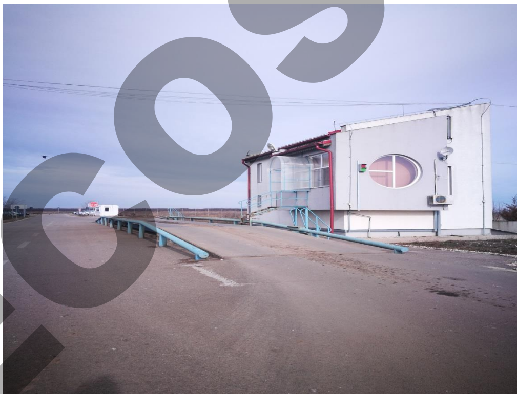
Figura 8. Clădire poartă, cântar, clădire administrativă
