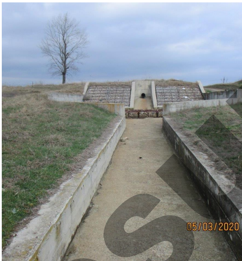
Figura 33. Evacuare ape uzate epurate în Pârâul Câinelui
