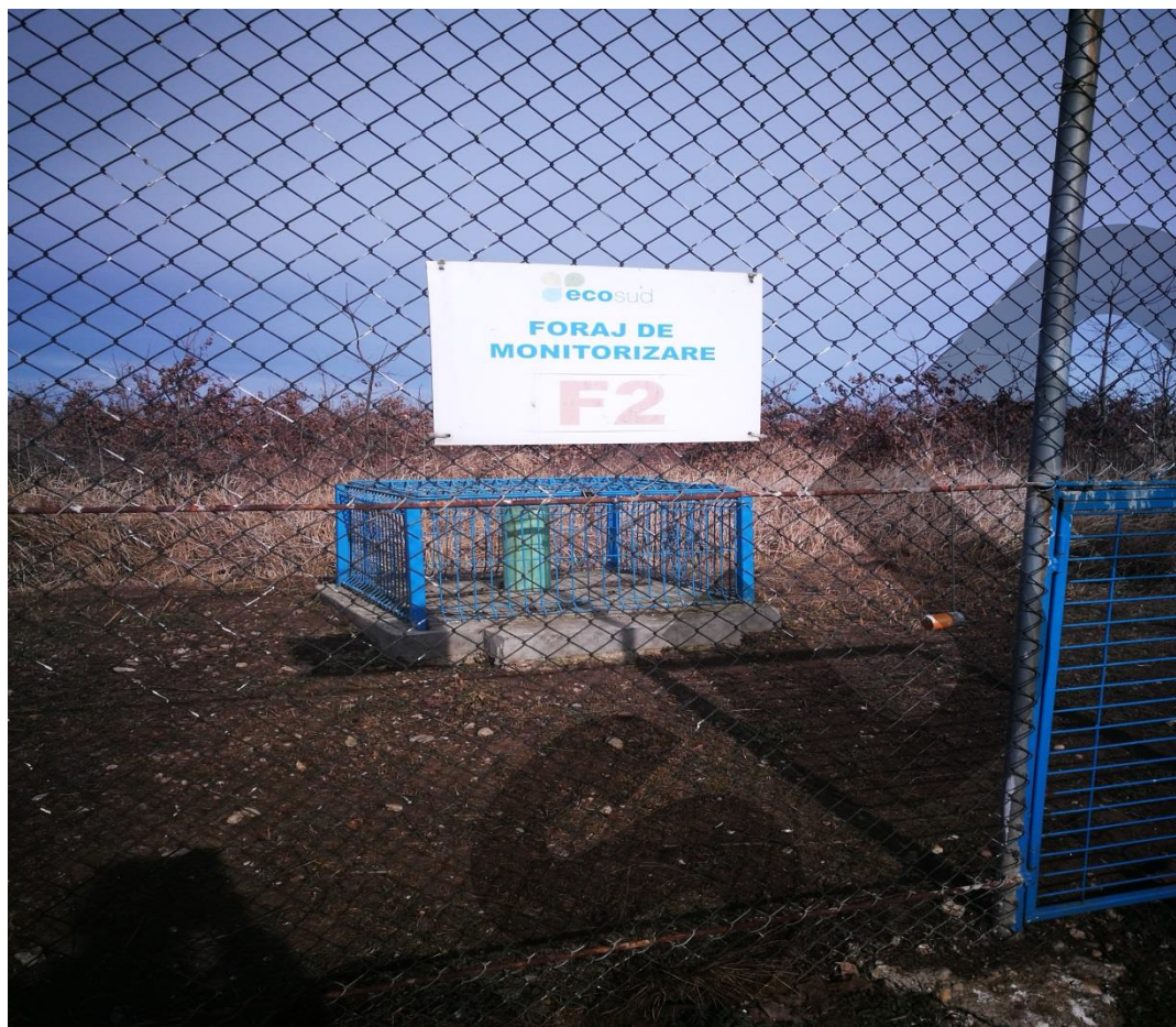
Figura 34. Puț de observație a calității apei subterane
