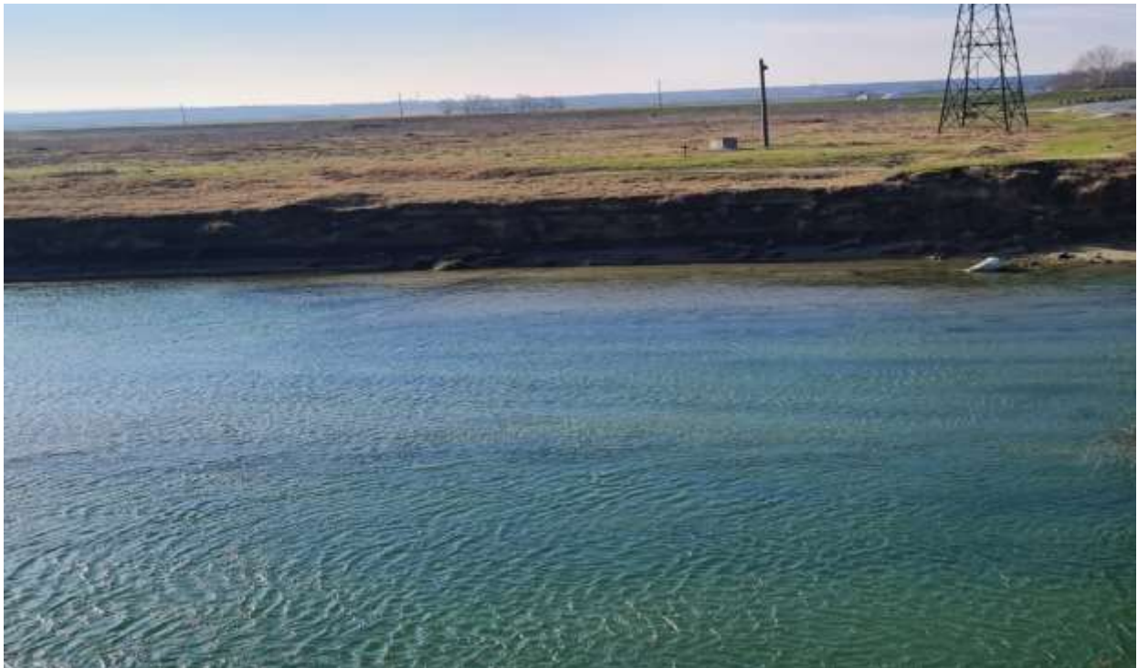
Fig. 6 – Zona pod DN54
