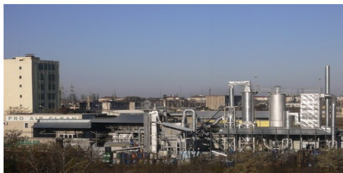
Fig. 7.4.1. Incineratorul SC PRO AIR CLEAN SA
