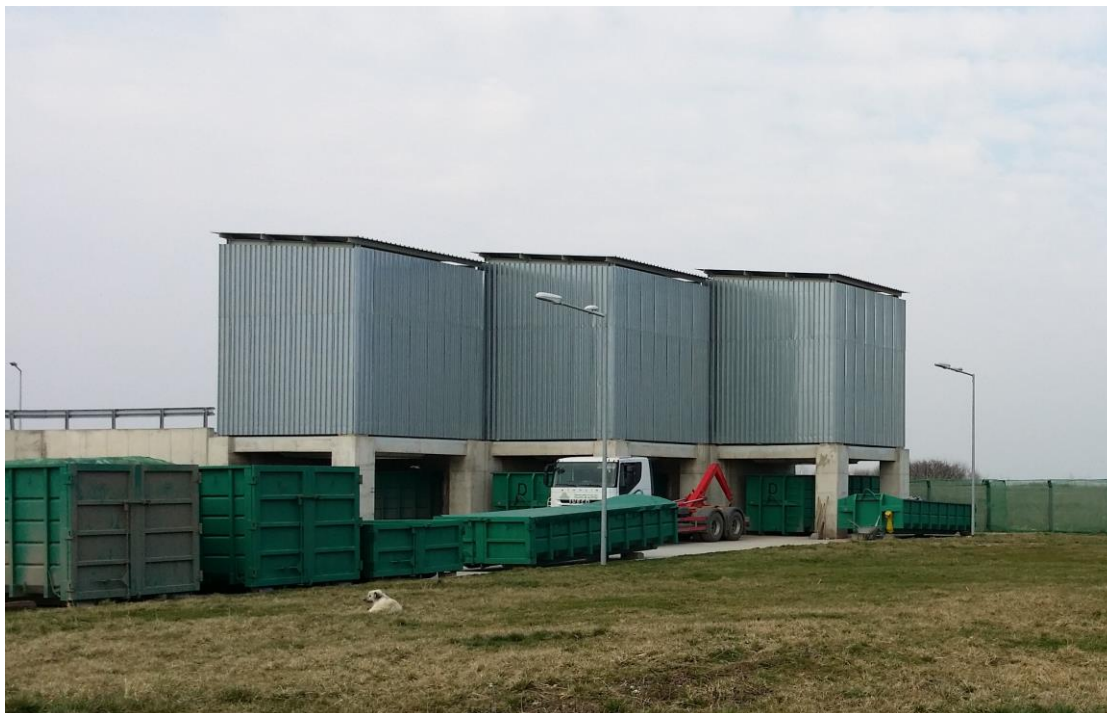
Fig. VII.10. - Centru de colectare deșeuri Deta
