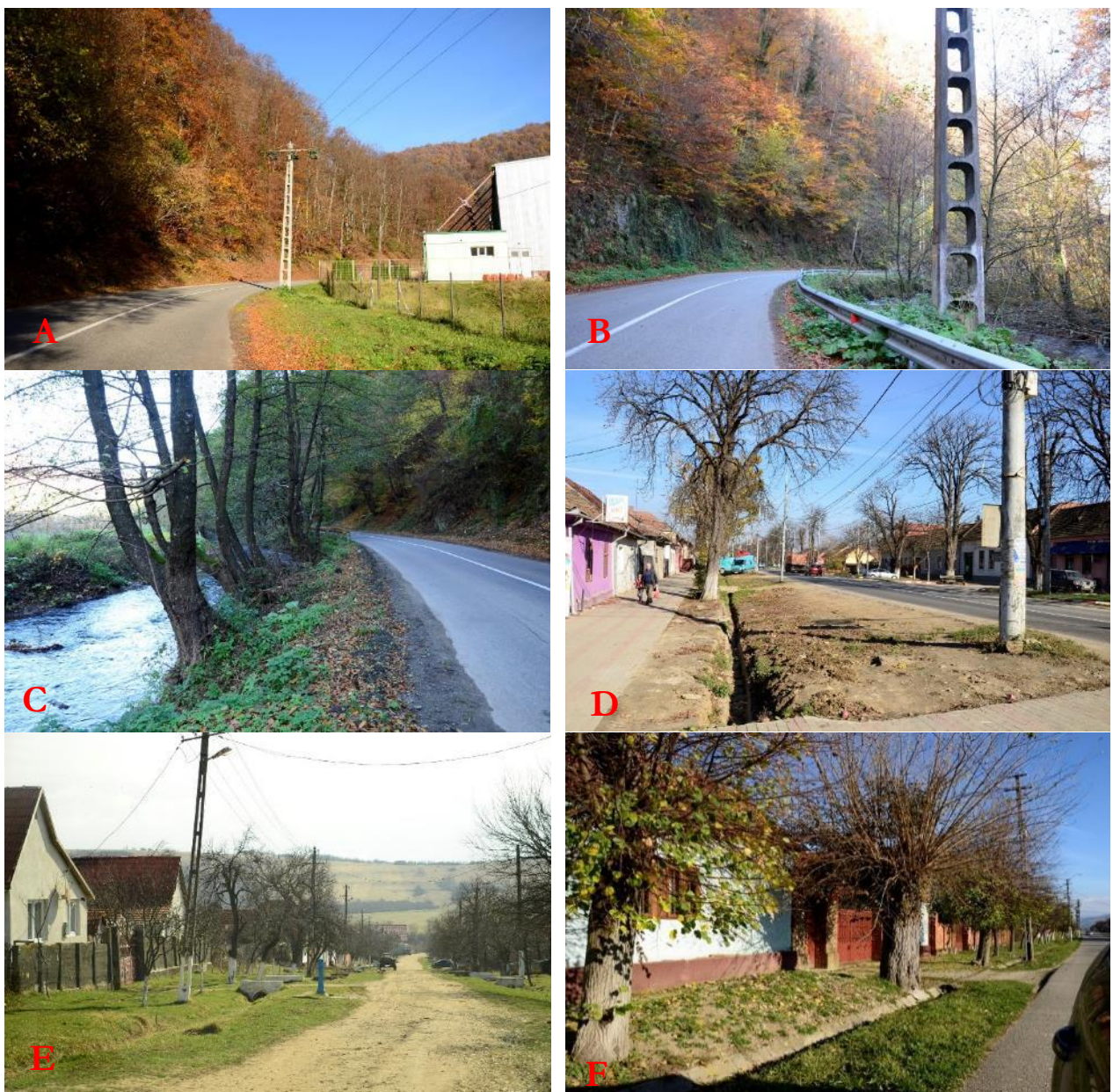
Figura nr. 5-41 Aspecte generale din zona de operare Z04 Făget – Colonia Fabricii (A, B), Tomești (C), Făget (strada principală) (D), Secaș (E), Sudriaș (F)
