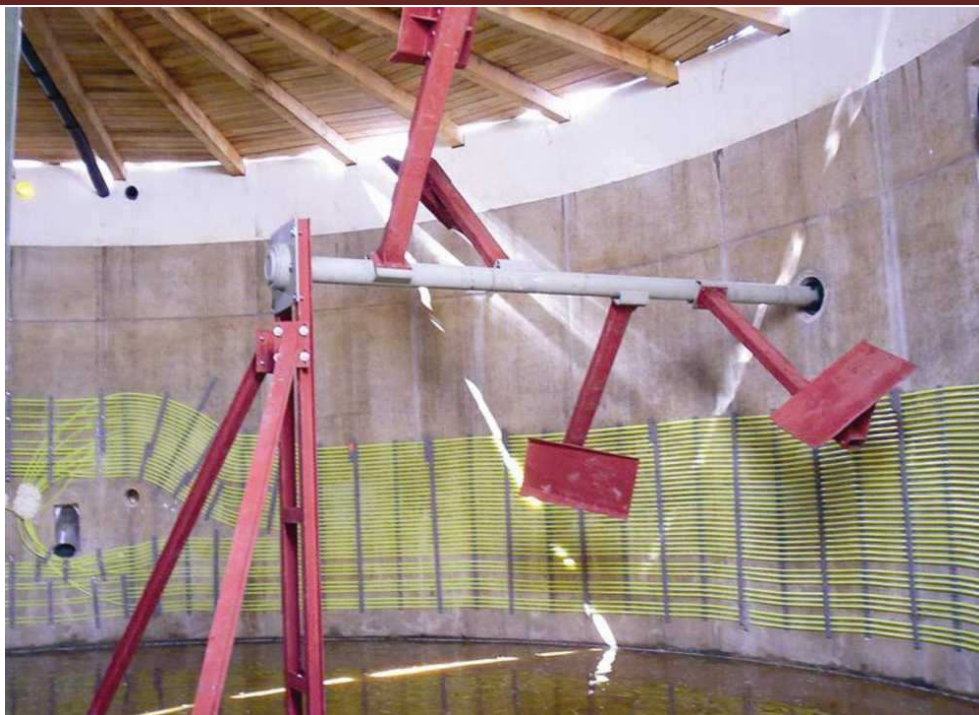
Figura 6. Serpentina amplasată pe pereți pentru termostatarea digestoarelor
