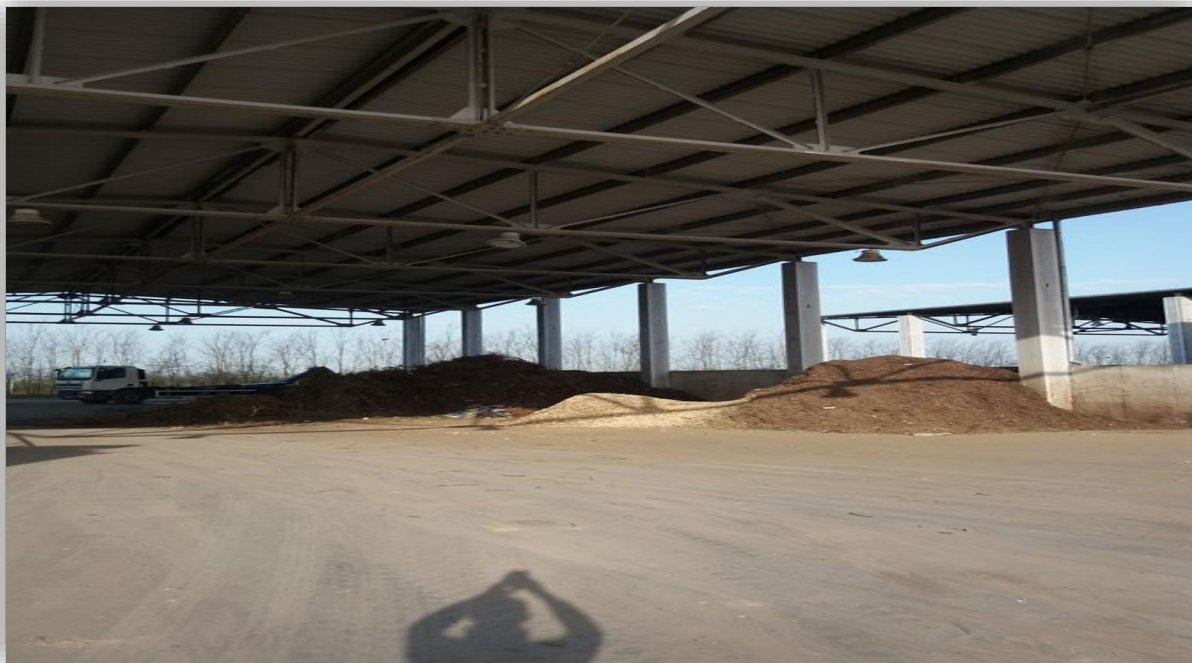
Fig.4. Instalatie de compostare in halda
