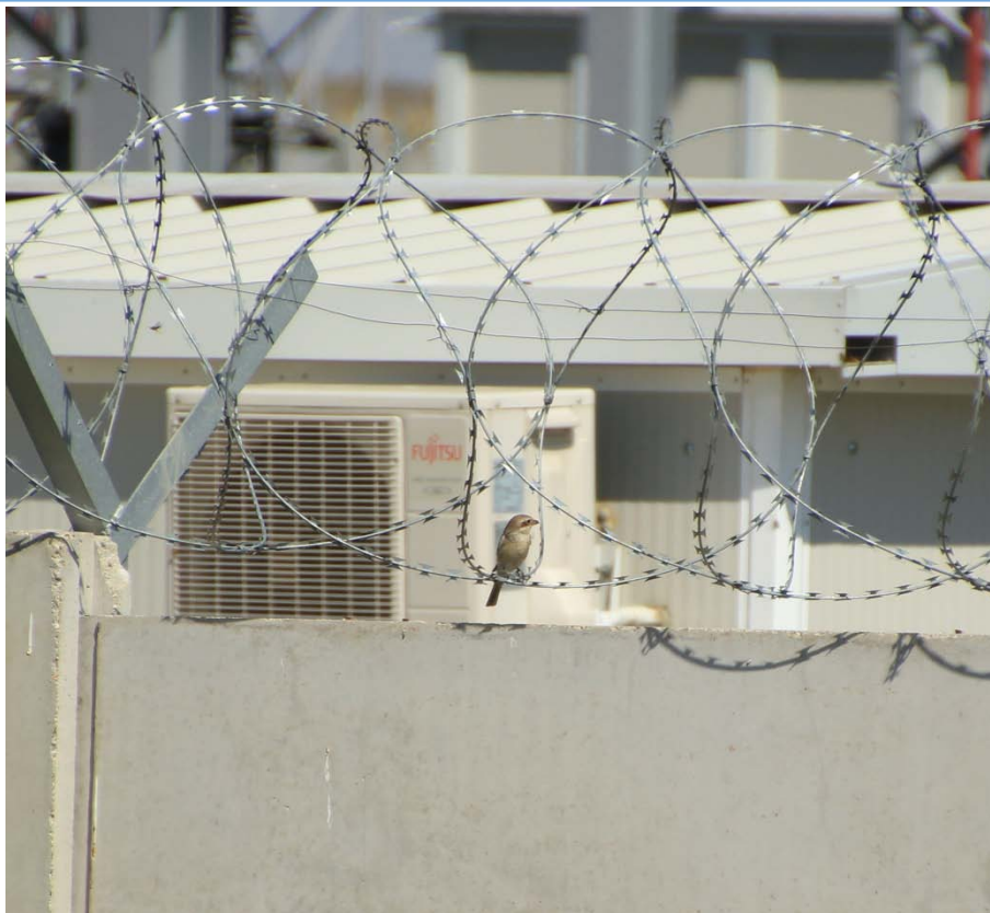
Lanius collurio observat la statia de transformare
