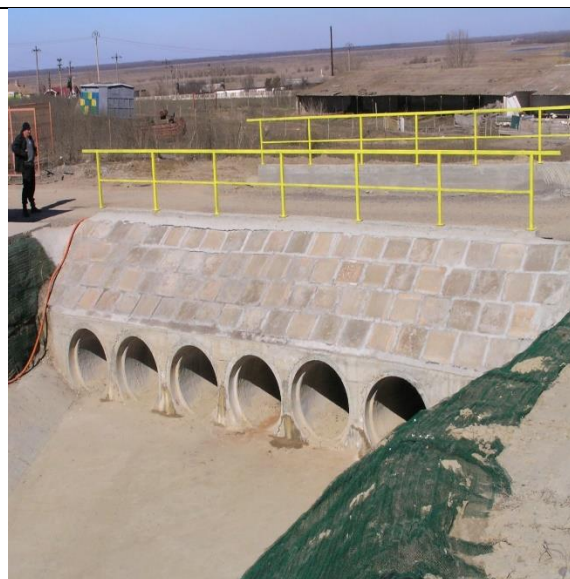
Figura 5.2. Podeț tubular zona traversare - intrare in incita
