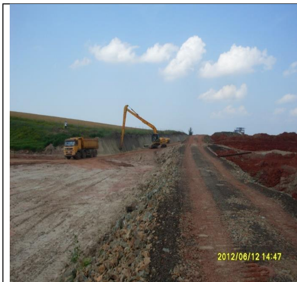
Figura 5.1. Executia canalului de deviere mal stang
