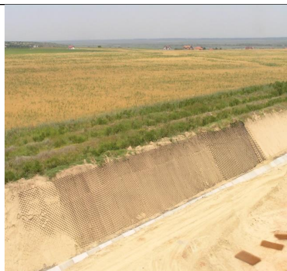
Figura 3.3. Canal rapid executat – in zona limitei de proprietate
