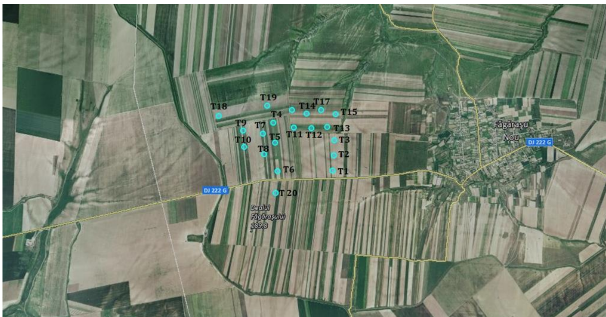
Figura nr. 3- Localizarea turbinelor din parcul eolian studiat
