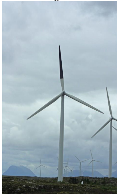
Fig.39 - pala turbina eoliana (2/3 din lungime ) vopsita in negru
