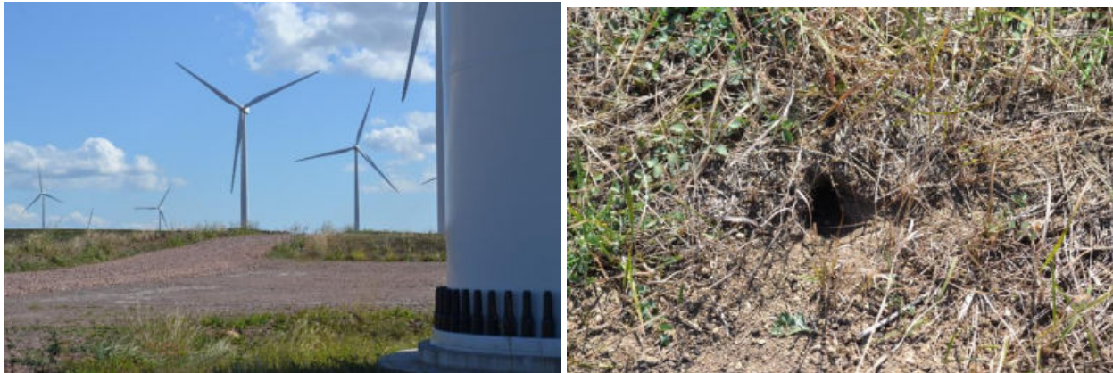
Fig. 22-23 Platforma turbina eoliana ( parc eolian in functiune din 2013 , care a fost construit pe terenuri arabile ) pe amplasamentul careia s-au identificat galerii ale speciei Spermophilus citellus
