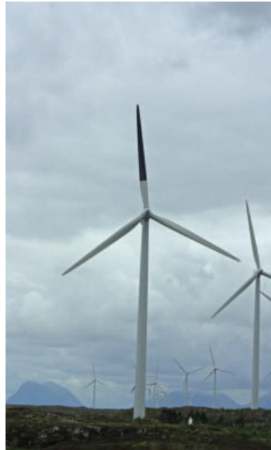
Fig.63 - pala turbina eoliana (2/3 din lungime ) vopsita in negru
