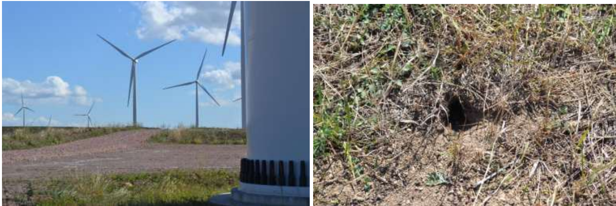
Fig. 23-24 Platforma turbina eoliana ( parc eolian in functiune din 2013 , care a fost construit pe terenuri arabile ) pe amplasamentul careia s-au identificat galerii ale speciei Spermophilus citellus
