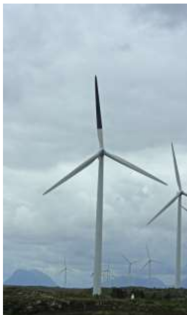
Fig.50 – masura de diminuare a impactului asupra avifaunei intr-un parc eolian din Norvegia -vopsirea a 2/3 din pala in negru
