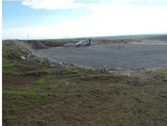
Fig.7- platforme de lucru -foto original Badea Gh.
