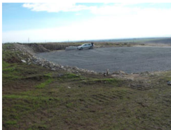
Fig.7- platforme de lucru -foto original Badea Gh.
