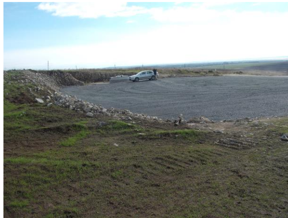
Fig.7- platforme de lucru -foto original Badea Gh.
