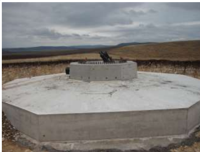
Fig . 9 - fundatie turbina eoliana- foto original Badea Gh.
