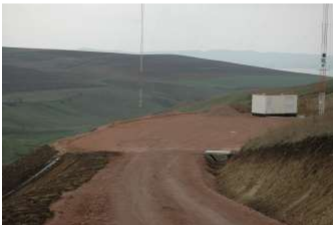
Fig.8 - platforme de lucru -foto original Badea Gh.
