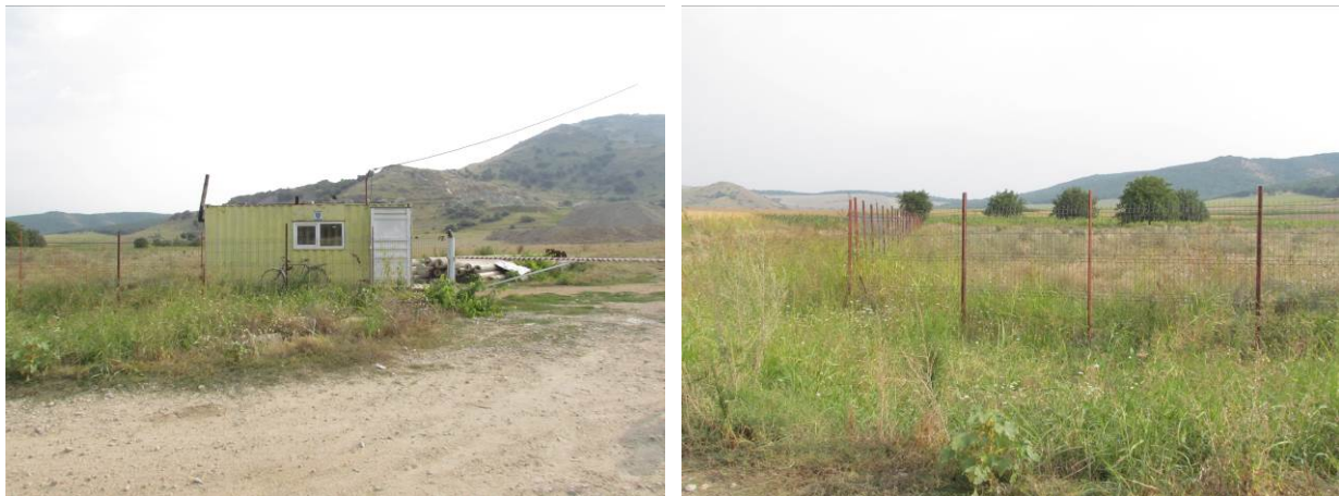
Cabina paznic si gard imprejmuitoar
