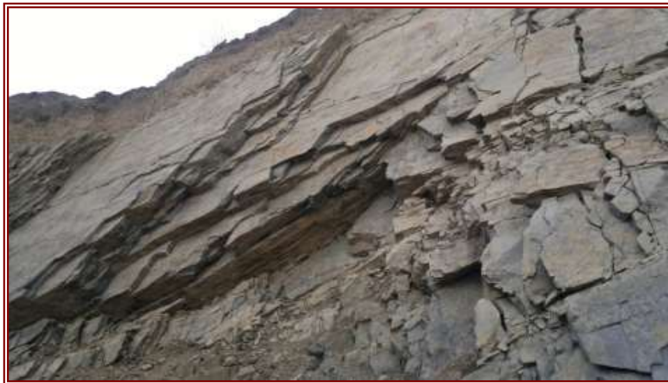
Fig . 11 - Structura stratificatiei in Frontul nordic vedere suplomb de fracturare pe fisuri (strate in secvente subtiri,centimetrice, puternic fisurate in suprafata)
