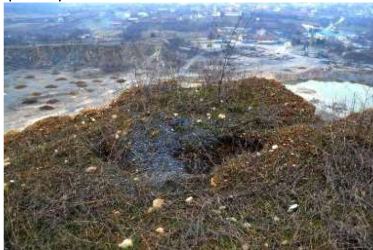
Fig. 28 - Fisura de desprindere fragment de roca din acoperis (coperta)
