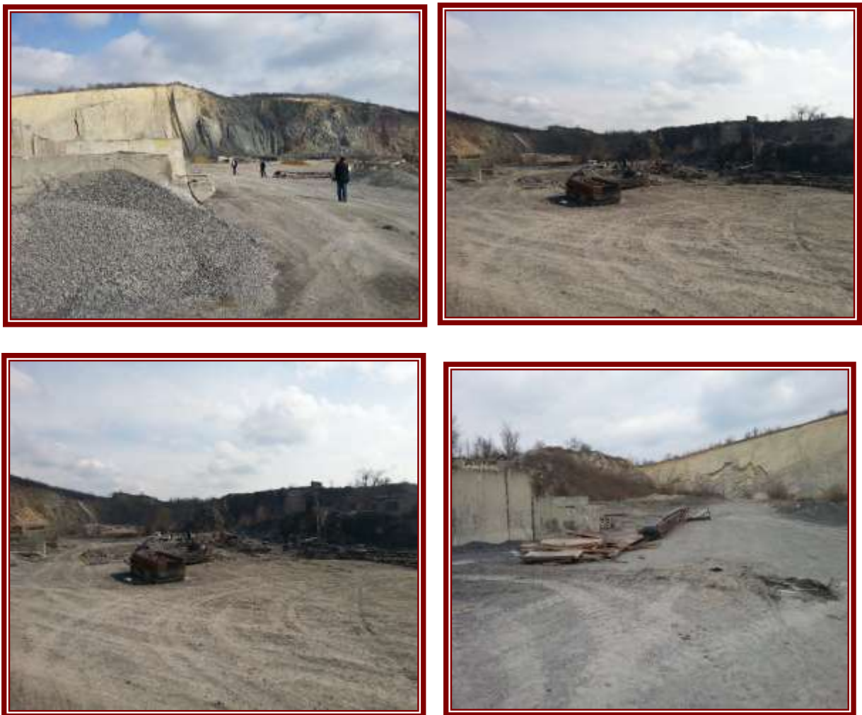
Fig. 17-20 : padocuri in curs de dezafectare si subansamble de fier vechi provenite de la demontarea/dezafectarea utilajelor tehnologice
