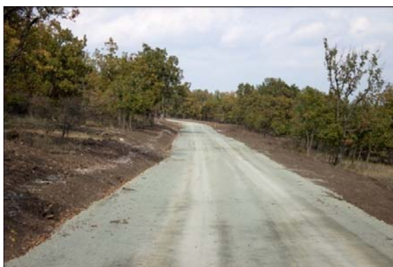
Fig. 25 – Aspecte de pe șantier – drum în zona împădurită către T5
