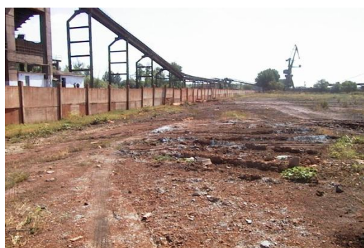
Figura nr. 2. Imagine inainte de realizarea Evaluarii riscului (la nivelul anului 2002)
