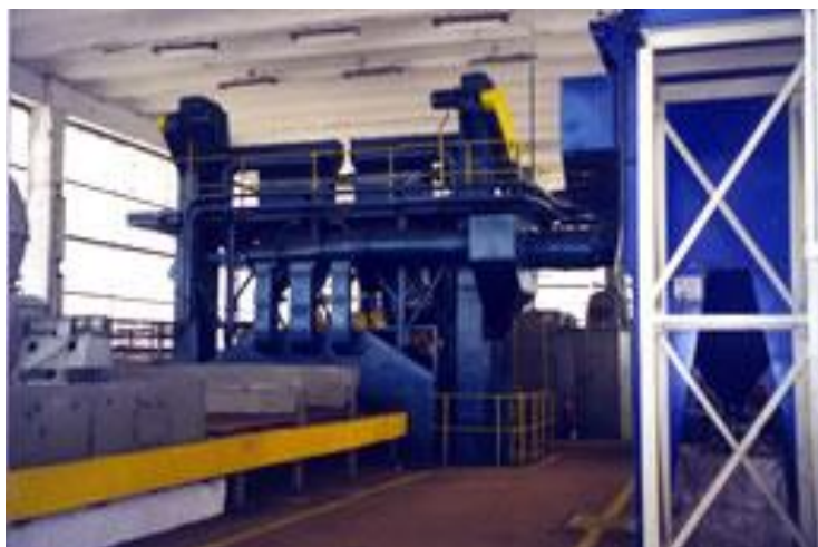
Figura nr. 22. Linia de sablare – vopsire (pasivizare) – Sectia Debitare
