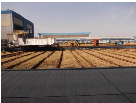
Figura nr. 49 – Cala de transfer mica
