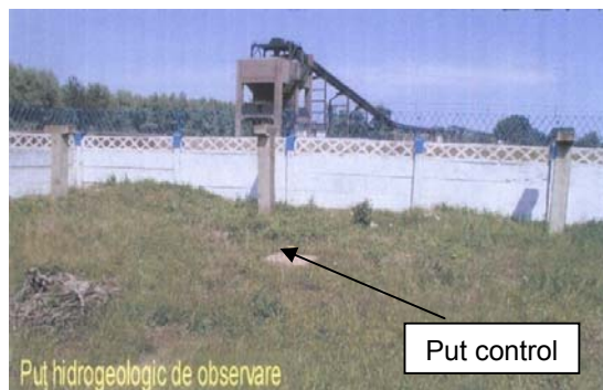
Figura nr. 5. Put de control – ape subterane
