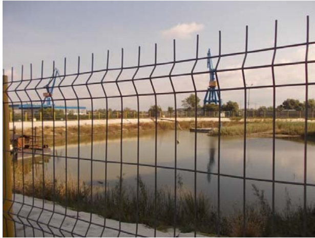
Figura nr. 50 – Hidrohalda
