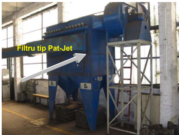
Figura nr. 8. Montare filtru Pat-Jet
