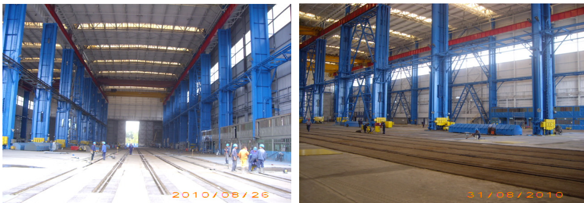
Figura nr. 15. Hala Montaj Nave – Cosmetizare/Reconditionare
