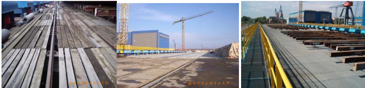
Figura nr. 16. Syncrolift – Inlocuirea platformei din lemn cu gratare metalice tip „Offshore”
