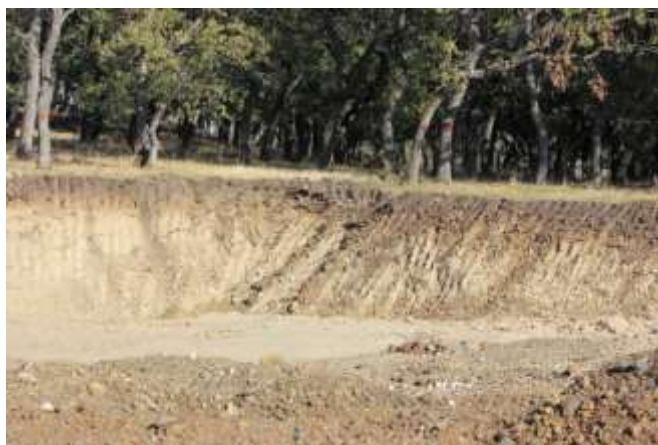
Fig. 8 – imagini cu taluze amenajate
