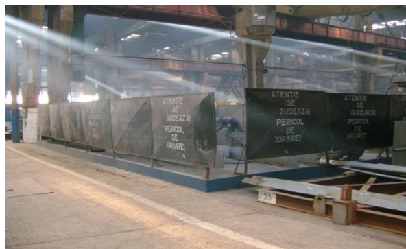
Figura nr. 50. Amenajarea imprejmuire zona sudura
