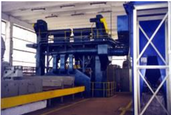
Figura nr. 5. Linia de sablare – vopsire (pasivizare) – Sectia Debitare
