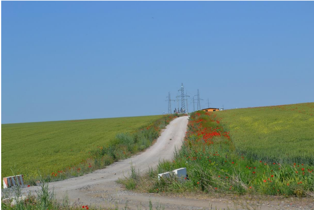
Fig. 24 – exemplare de maci ( Papaver rhoeas ) pe drumul de acces la statia electrica Sarichioi
