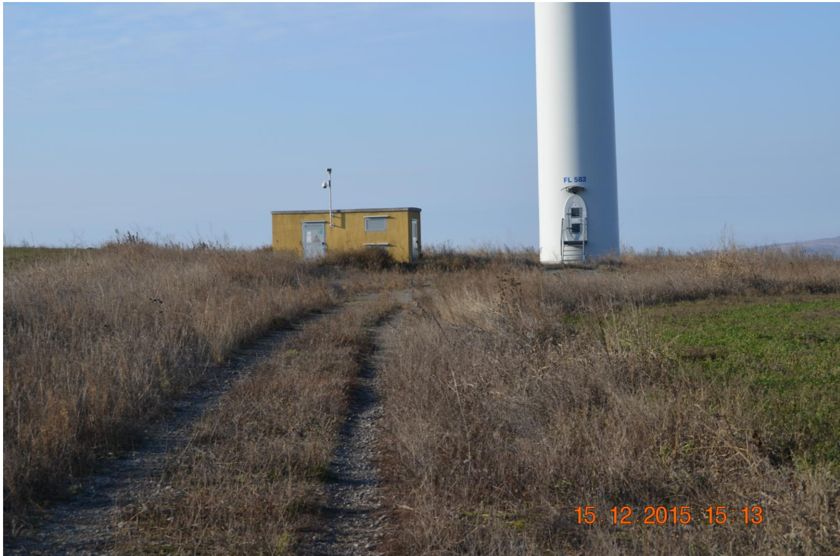
Foto 2. Aspect al terenului în arealul din vecinătatea turbinei FL 582 (partea de V)
