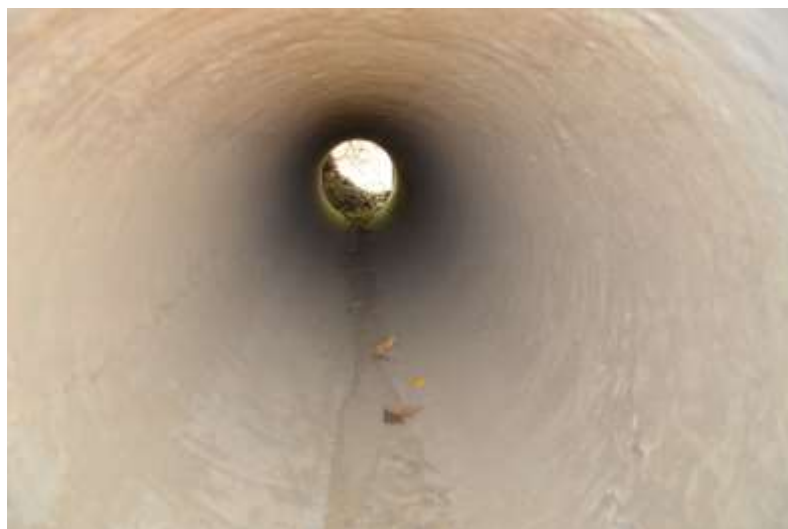
Fig.19. Subtraversare pe DE 137 Calea Săpată pentru reptile executată de Romgranit Lines
