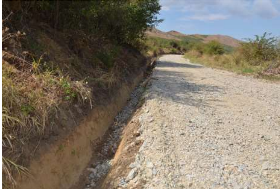
Fig. 20 – Șanțuri de preluare – drenare ape pluviale pe cale de transport executate de Romgranit Lines
