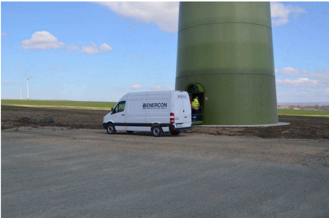
Activitati de mentenanta la nivelul turbinelor eoliene.
