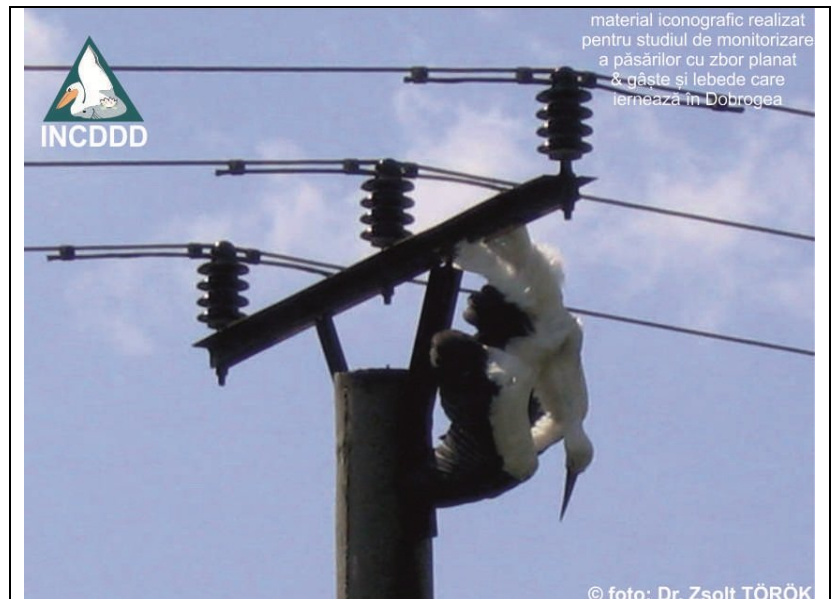
Fig. 1.4. Exemplar tânăr de barză albă ( Ciconia ciconia ) decedat în urma contactului cu un cablu al rețelei de transport aerian a curentului electric (august; zona Horia, jud. Tulcea).
