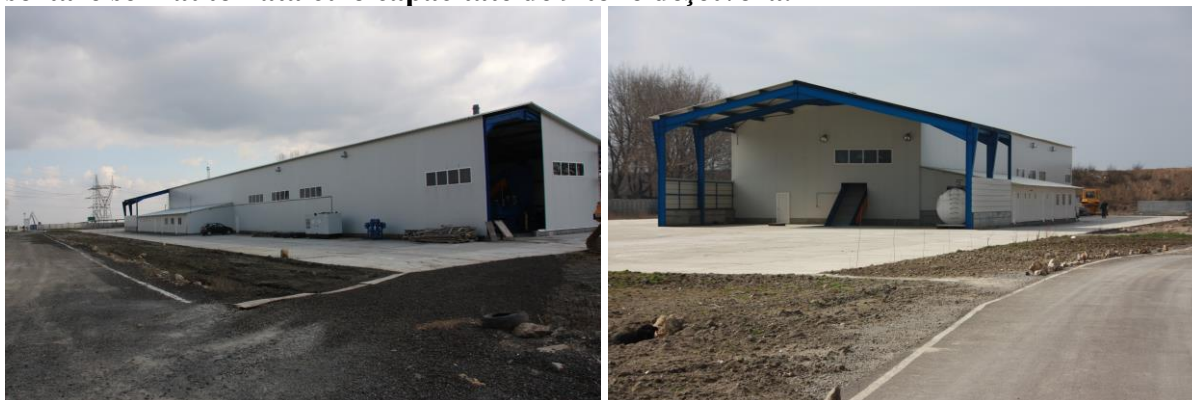
Imagini reprezentând stația de sortare semiautomată a deșeurilor ECOREC Tulcea
