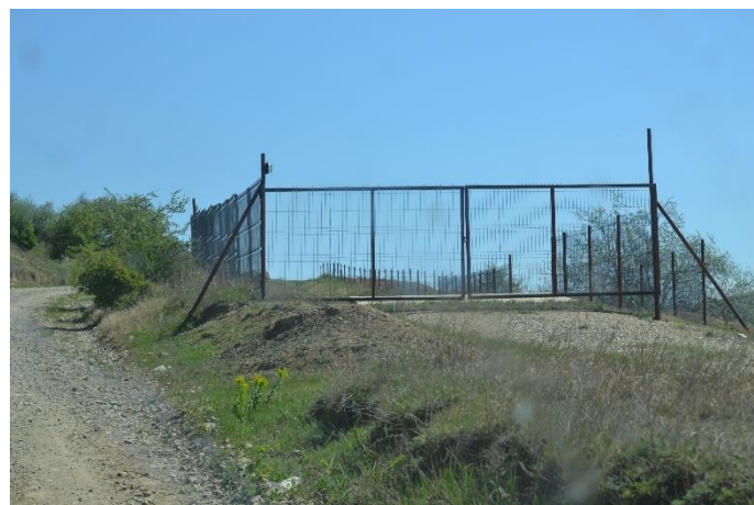
Fig. 5 – imagine împrejmuire cariera -zona pod-cantar
